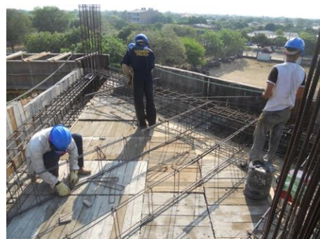
Armado de acero para Placas
